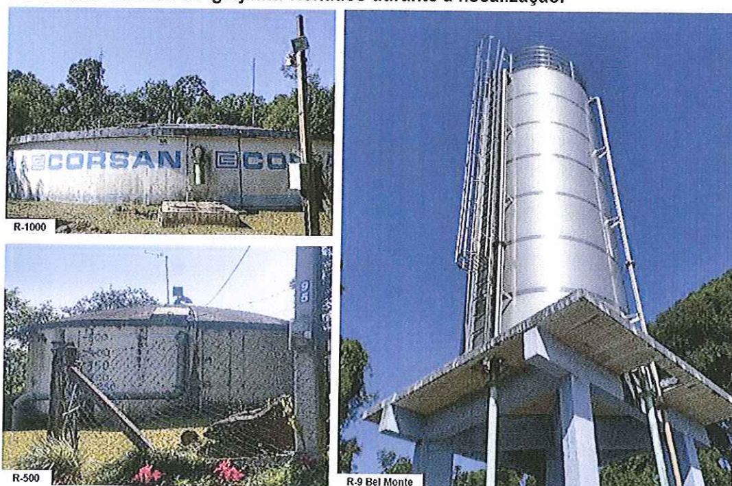
Figura 01: Reservatórios de Igrejinha visitados durante a fiscalização.
