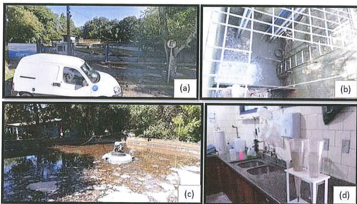
Figura 2: Registro fotográfico da fiscalização à ETE Jardim das Figueiras, onde: (a) vista frontal; (b) Gradeamento; (c) Tanque de lodo ativado e (d) Laboratório.
