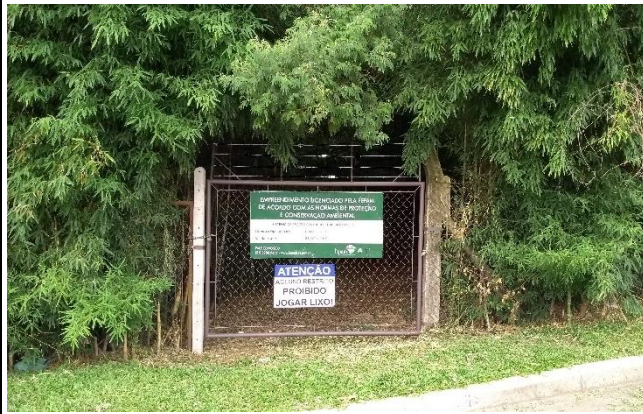
Foto 1. Entrada da ETE
