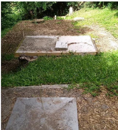
Foto 5. Vista interna sobre a fossa séptica
