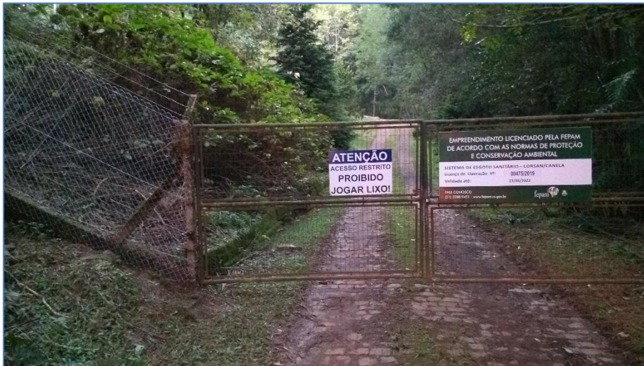
Foto 1. Entrada da ETE.
