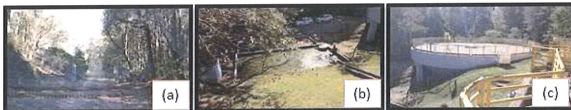
Figura 2: Registro fotográfico da fiscalização à ETE Santa Terezinha, onde: (a) vista frontal; (b) pátio interno com os leitos de secagem e (c) pátio interno com reator anaeróbico.
