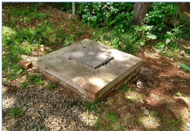
Foto 6. Novo PV de saída. Ponto de amostragem do efluente.
