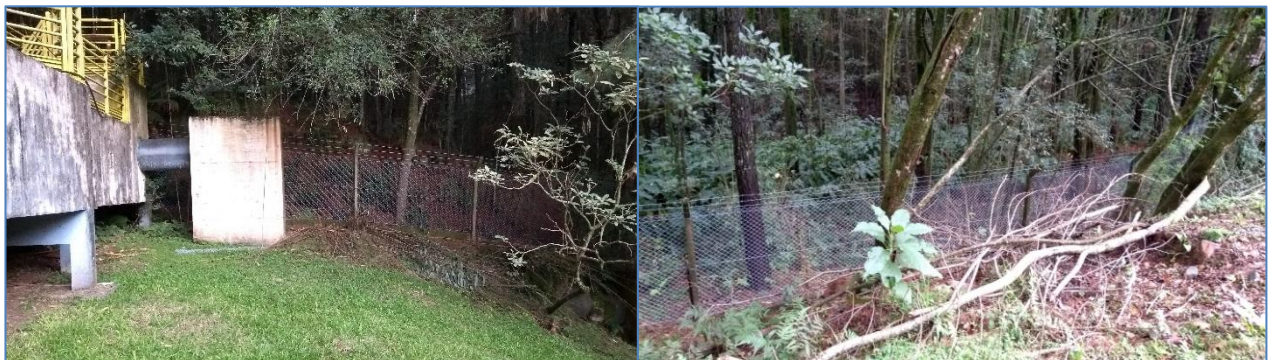
Foto 12. Reforma do cercamento.
