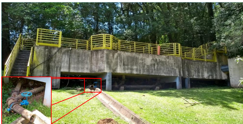
Foto 8. Novo registro de expurgo das caixas de areia.
