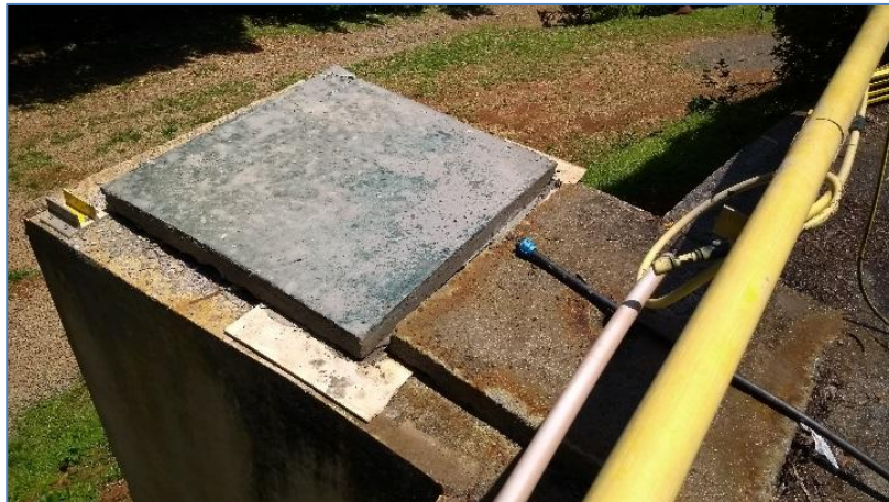
Foto 10. Nova tampa na saída do reator.
