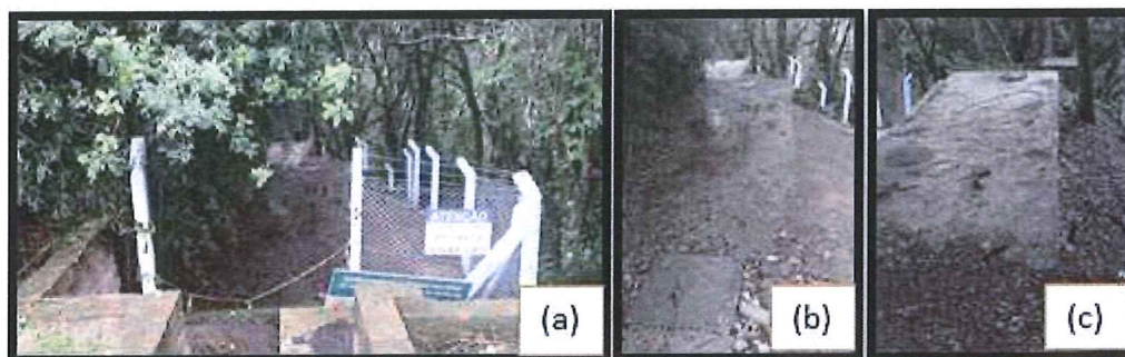
Figura 2: Registro fotográfico da fiscalização à ETE Chacrão, onde: (a) vista frontal; (b) pátio interno com os conjuntos fossa-filtro e (c) Pátio interno com detalhe do filtro.
