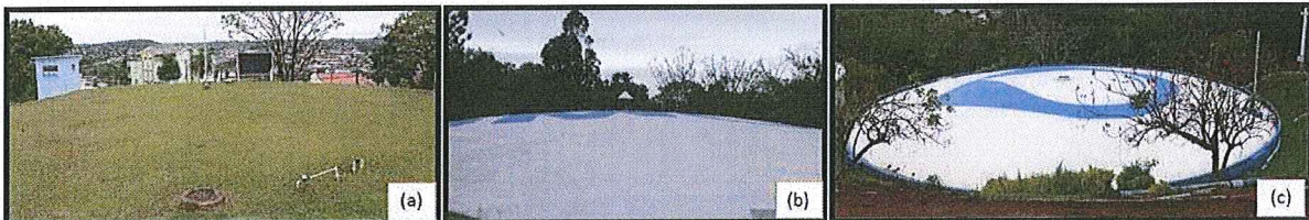
Figura 4: Registro fotográfico dos Reservatórios: (a) Reservatório RES001; (b) Reservatório RES002 e (c) Reservatório RES003.
