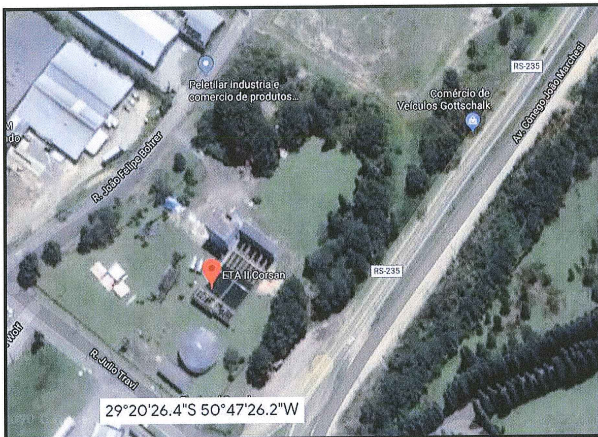
Figura 2: ETA-II do sistema integrado Canela e Gramado, coordenadas 29°20'26.4"S e 50°47'26.2"W. Fonte: Disponível no Google Earth, acesso em 27 de janeiro de 2020.
