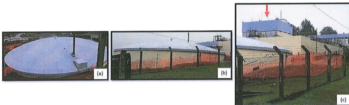
Figura 4: Reservatórios localizados junto à ETA – I, onde (a,b) reservatório R-1 de 1.500 m 3 ; e (c) reservatório R-2 de 250 m 3 .
