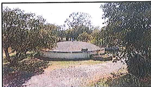
Figura 4: Reservatório R-01 localizado junto à ETA.
