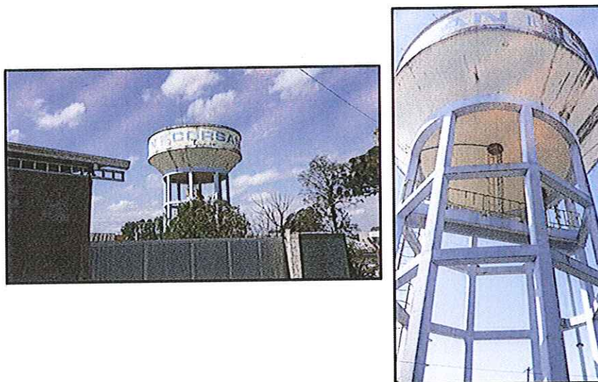
Figura 6: Reservatório R-04 localizado junto à unidade de atendimento aos usuários.
