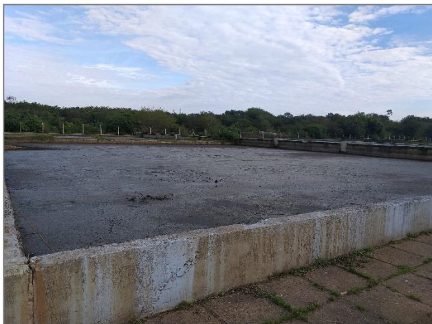
Figura 29. Leito de secagem em uso.
