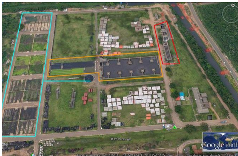
Figura 1. Vista aérea da ETE Mato Grande.
