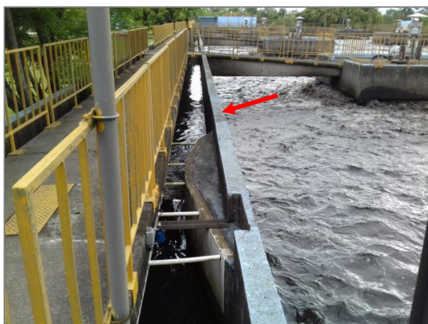
Figura 25. Canal de recirculação de lodo.
