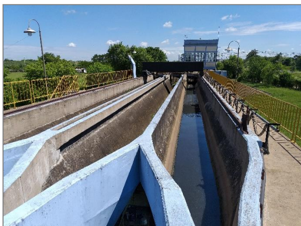
Figura 23. Desarenador.
