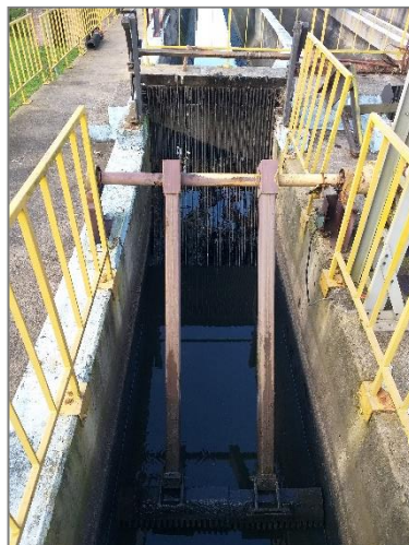
Figura 22. Gradeamento com rastelo mecanizado
