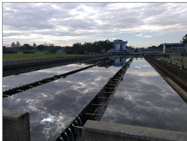
Figura 26. Decantador.
