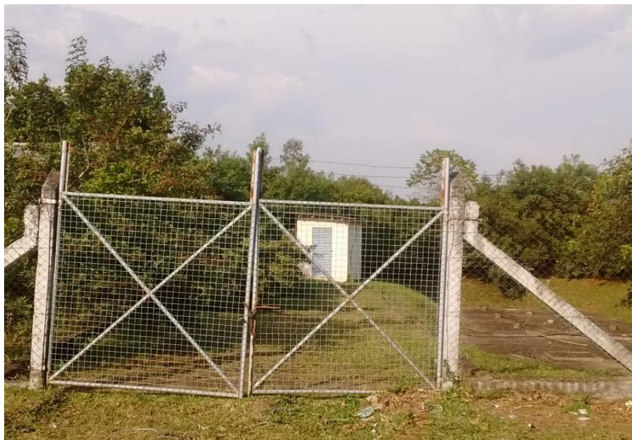
Figura 6: Vista da ETE e seu portão de entrada.
