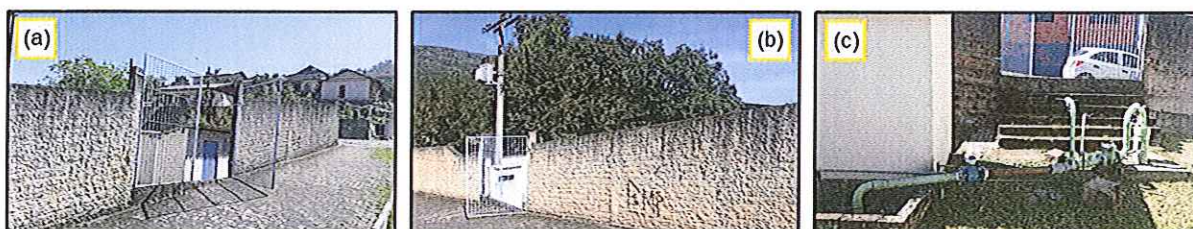
Figura 3: Registro fotográfico do Poço IGR-02A, onde: (a-b) vista externa do portão de acesso, e; (c) estrutura da captação subterrânea abaixo do nível da rua.
