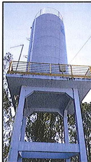
Figura 3: Registro fotográfico do reservatório R11, elevado, de inox, 100 m 3 .
