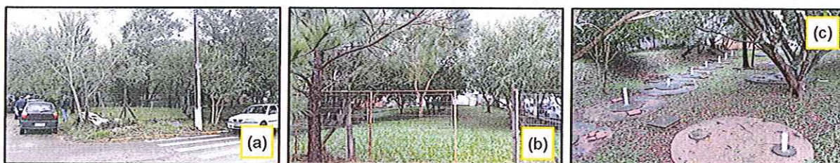
Figura 3: Registro fotográfico da fiscalização à ETE Loteamento Horizonte, onde: (a) vista frontal; (b) acesso lateral por meio de portão, e; (c) pátio interno com os conjuntos fossa-filtro.
