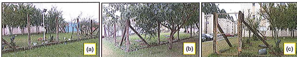
Figura 4: Registro fotográfico da fiscalização à ETE 2, onde: (a) vista frontal; (b) vista de fundos, e; (c) portão de acesso.
