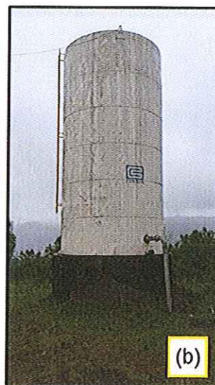
Figura 5: Registro fotográfico da fiscalização, onde: (a) elevatória EB-11, e; (b) reservatório apoiado R5.
