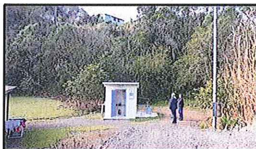
Figura 2: Registro fotográfico do Poço 08 necessitando de identificação e cercamento.
