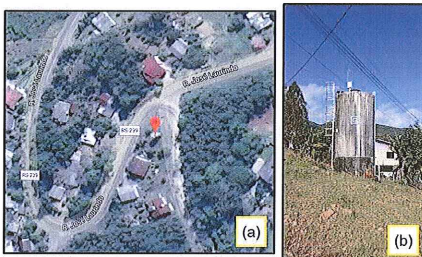
Figura 3: (a) Localização do reservatório R8. Fonte: disponível no Google Maps, acesso em 26 de agosto de 2019, e; (b) registro fotográfico do reservatório.
