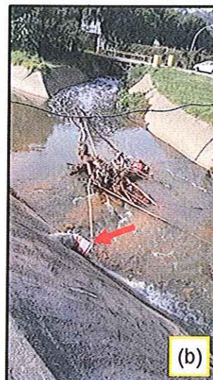
Figura 2: Registro fotográfico executado na fiscalização à ETE Moradas, onde: (a) placa padrão Fepam, e; (b) efluente descartado no Arroio Sapucaia.
