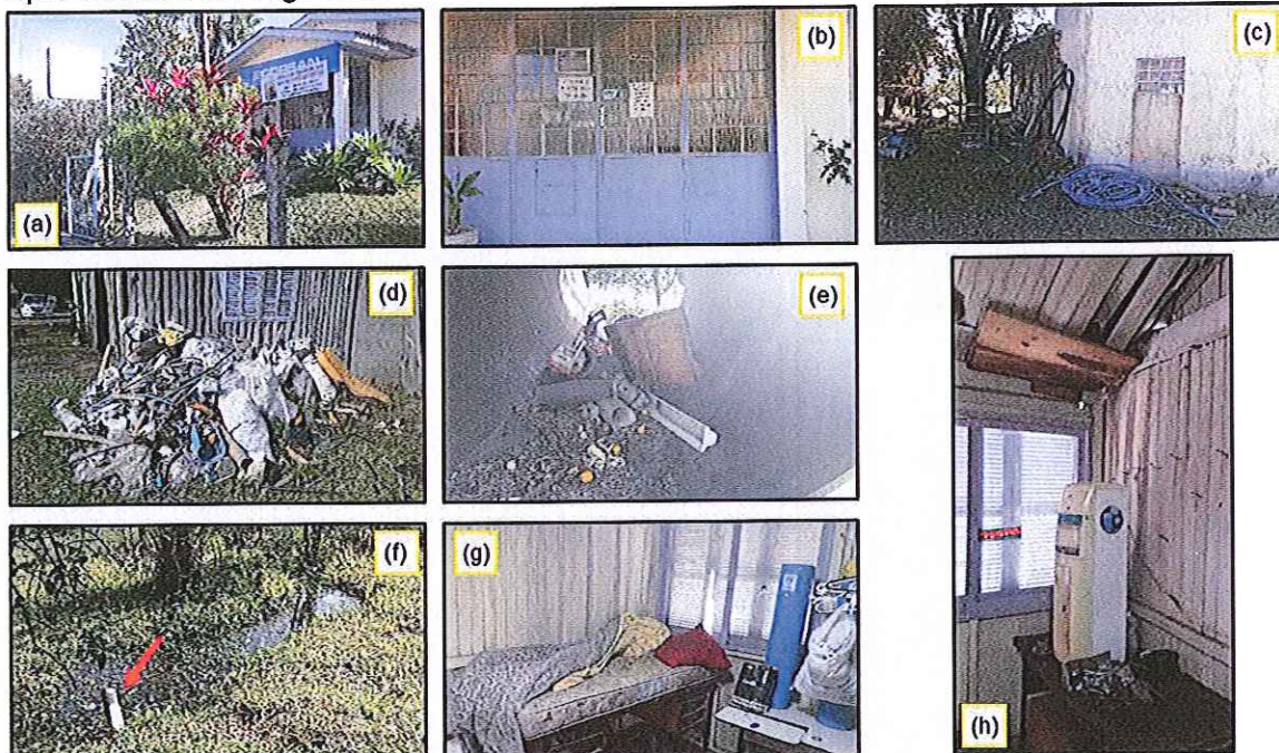
Figura 6: Registro fotográfico dos setores comercial e operacional, onde: visão geral da entrada do escritório de atendimento; (b) porta de entrada do escritório com indicação do horário de atendimento é de difícil visualização; (c-e) acúmulo de resíduos ao longo do pátio da unidade; (f) tubulação localizada nos fundos da unidade com despejo indeterminado; (g-h) área destinada aos funcionários necessitando revitalização.
