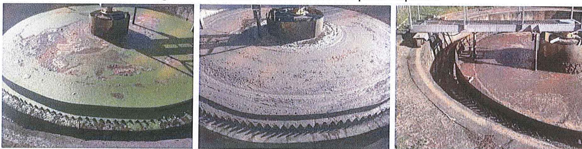
Figura 5: Decantadores secundários com ponte raspadora
