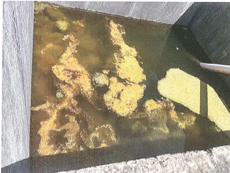
Figura 15: Tanque de acúmulo de lodo na ETE Reserva da Serra
