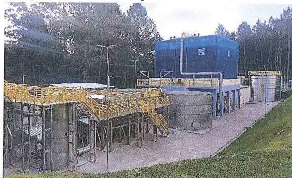
Figura 18: Novas instalações da ETE Santa Terezinha
