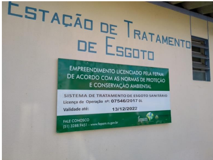
Figura 9: Vista da entrada da ETE.
