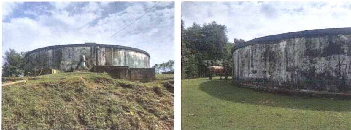
Figura 4: Vista do reservatório R-01
