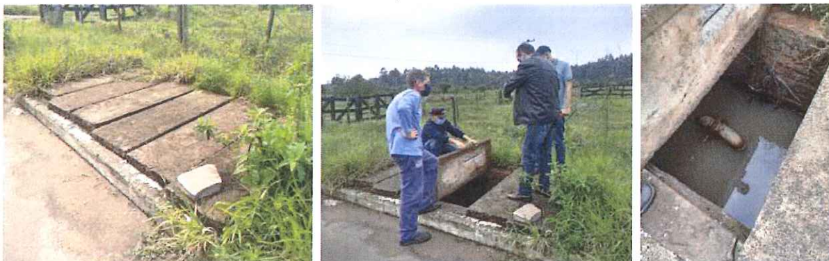
Figura 2: Vista da Estação de Bombeamento EBAT-3
