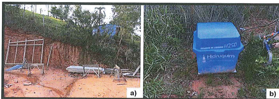
Figura 5: Sistema de reservação e tratamento da Águas da Nascente. a) Reservatório; b) Equipamento dosador de cloro
