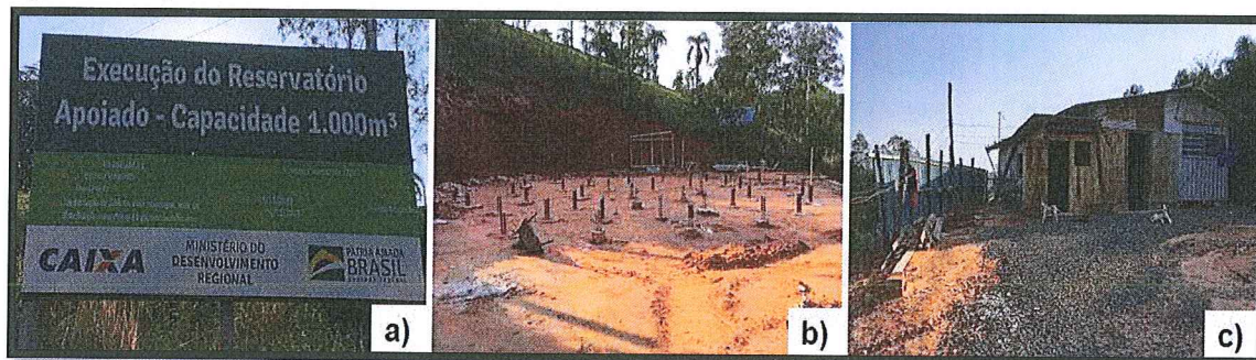
Figura 7: Registros fotográficos da visita à construção do reservatório. a) Placa de identificação da construção; b) Vista das fundações do reservatório; c) Vista da casa da empreiteira responsável pela obra.
