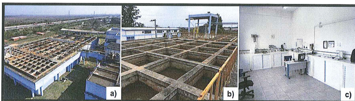
Figura 8: Estação de Tratamento de Água Rio Branco. a) Vista da ETA; b) Vista dos floculadores; c) Vista do Laboratório da ETA
