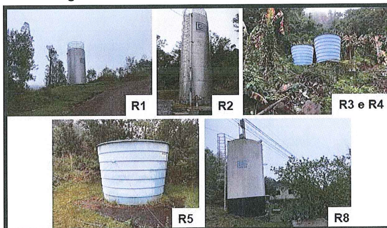
Figura 7: Vista dos Reservatórios Fiscalizados.
