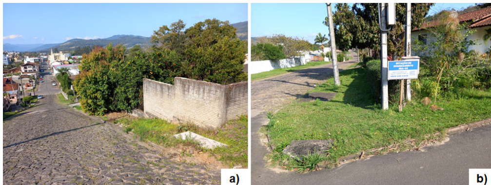
Figura 23 – Registros fotográficos dos locais de instalações do VRP e do booster. a) VRP na esquina da rua Pedro Schneider com a rua Carlos Kroeff; b) Booster na esquina rua Pedro Schneider com a rua Afonso Grinss.
