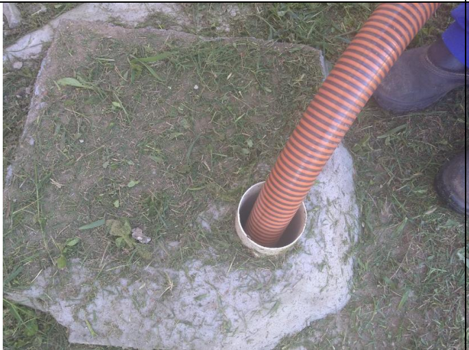
Limpeza de fossa
