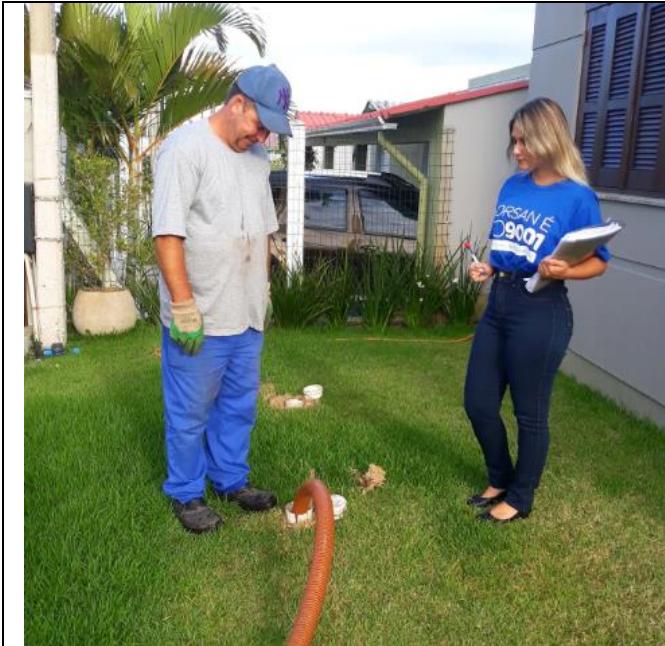
Acompanhamento das Limpezas de Fossas sépticas
