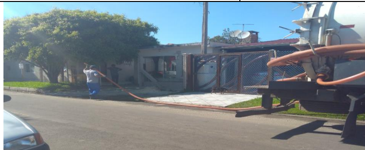
Chegada ao imóvel-Manobra de instalação
