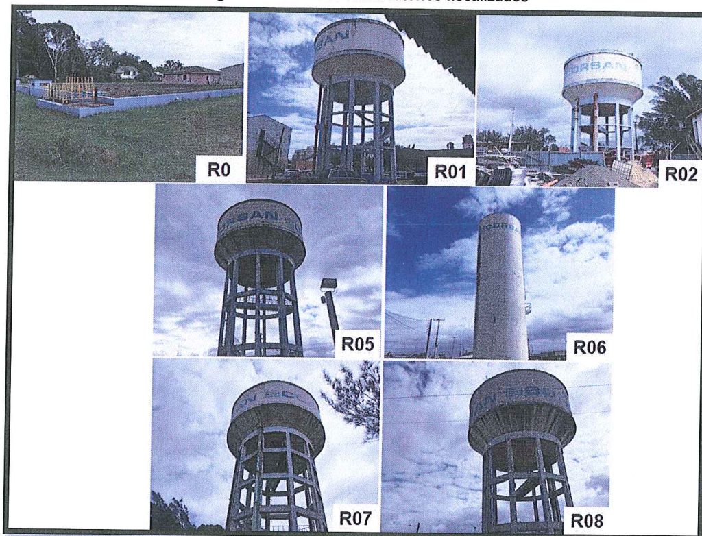
Figura 14: Vista dos Reservatórios fiscalizados
