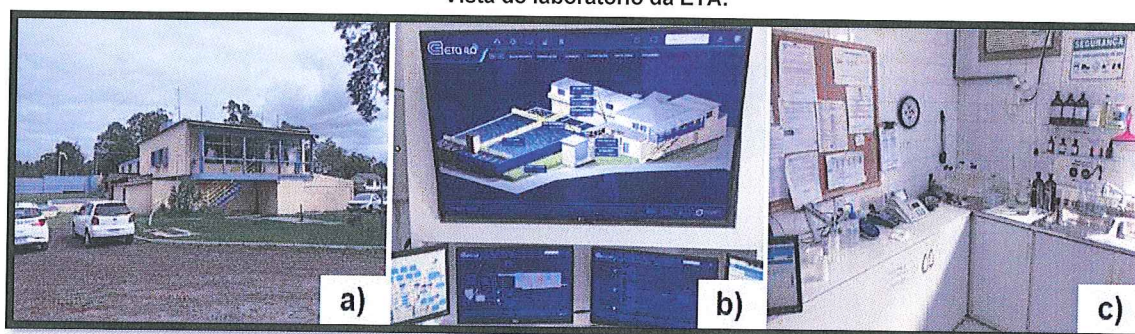
Figura 11: Vistas da ETA Tramandaí. a) Vista da sede da ETA; b) Vista do supervisório de controle do sistema 4.0; c) Vista do laboratório da ETA.
