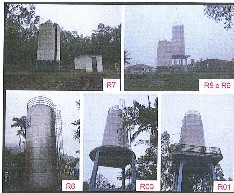
Figura 4: Vista dos Reservatórios Fiscalizados
