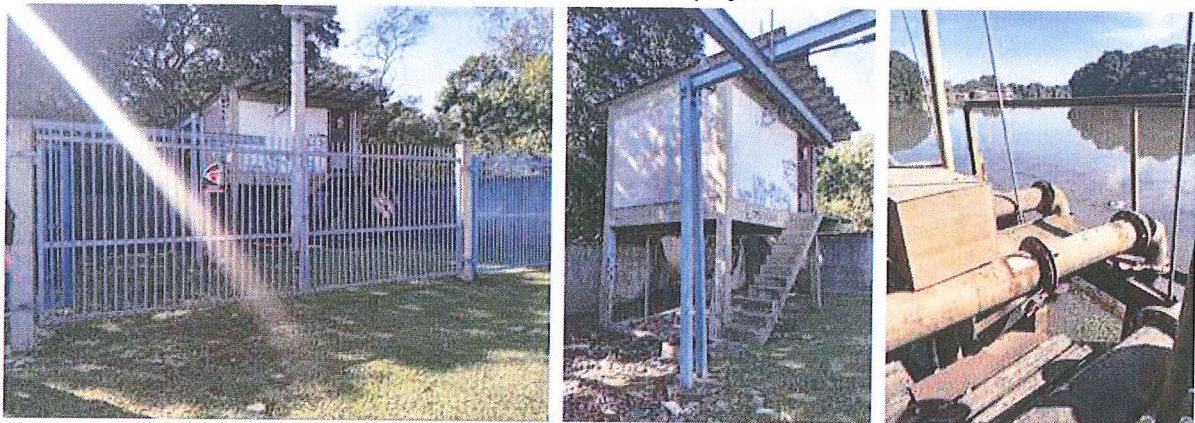
Figura 2: Estrutura da captação
