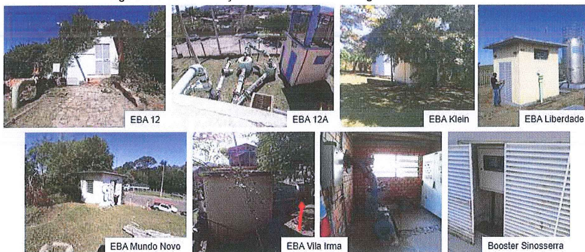
Figura 1: Vista das Estações de Bombeamento de Água Tratada fiscalizadas
