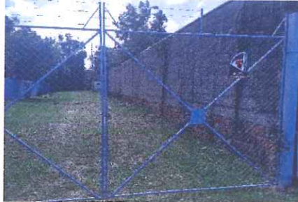
Figura 3: Entrada da área da captação com cercamento
