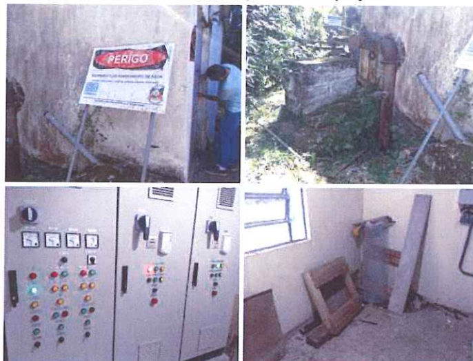
Figura 2: Estrutura predial da captação
