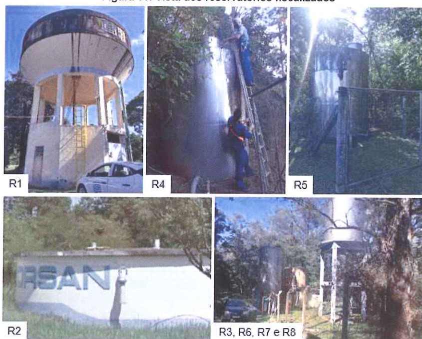
Figura 11: Vista dos reservatórios fiscalizados
