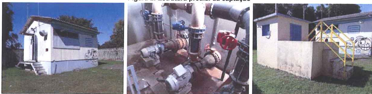
Figura 2: Estrutura predial da captação
