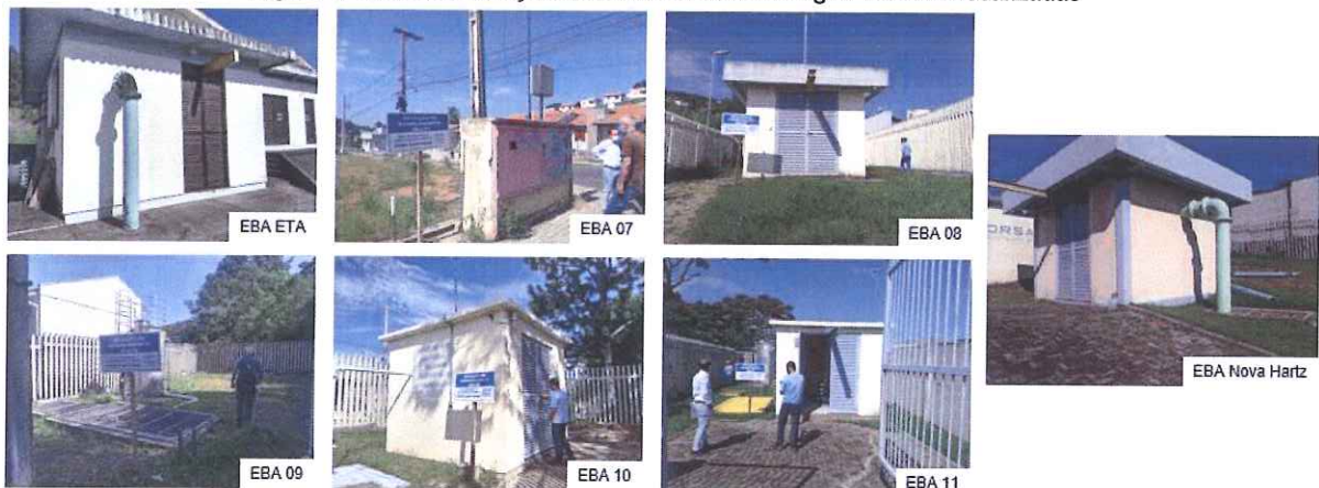
Figura 7: Vista das Estação de Bombeamento de Água Tratada fiscalizadas
