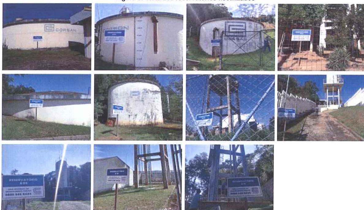
Figura 8: Vista dos reservatórios fiscalizados
