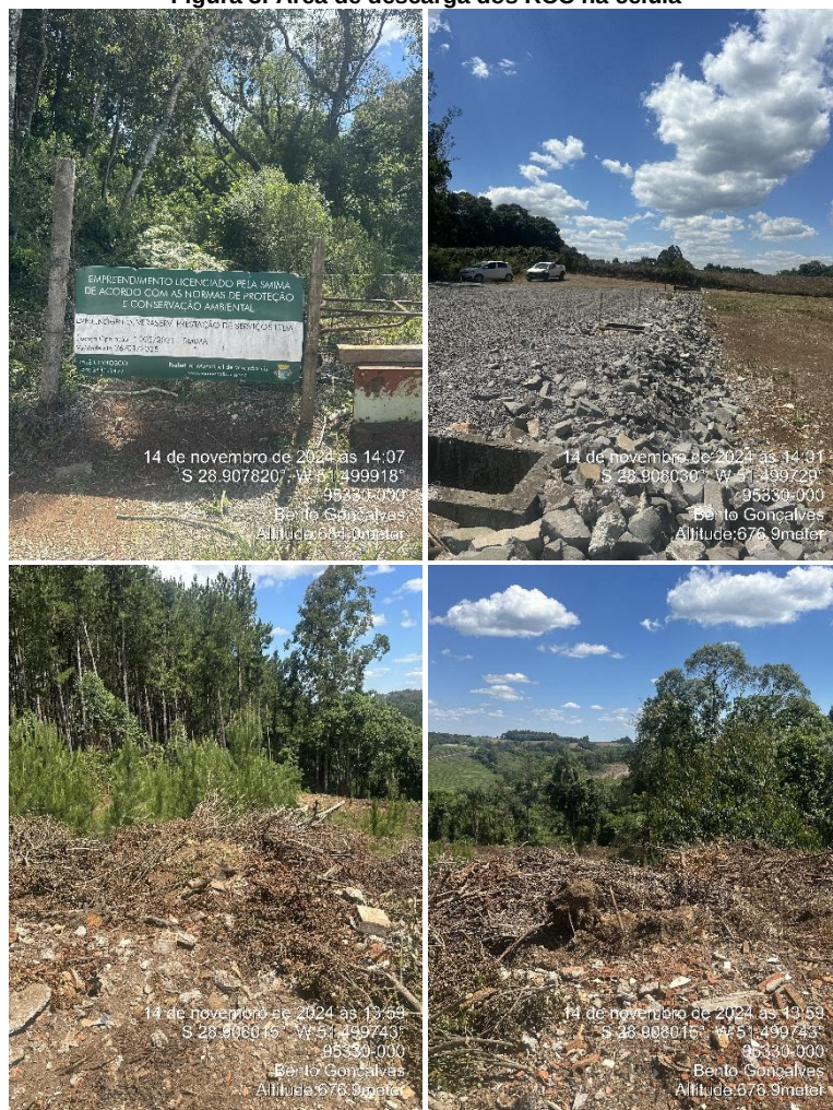
Figura 3: Área de descarga dos RCC na célula
