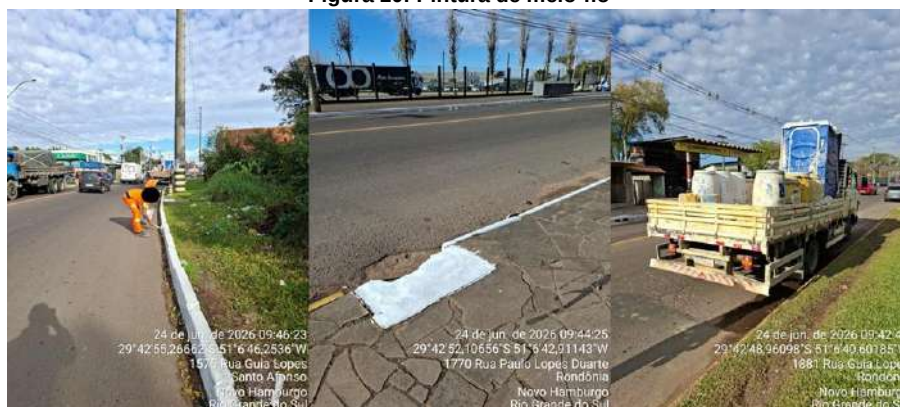
Figura 10: Pintura de meio-fio
