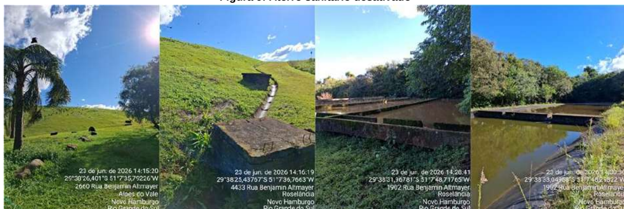
Figura 9: Aterro sanitário desativado
