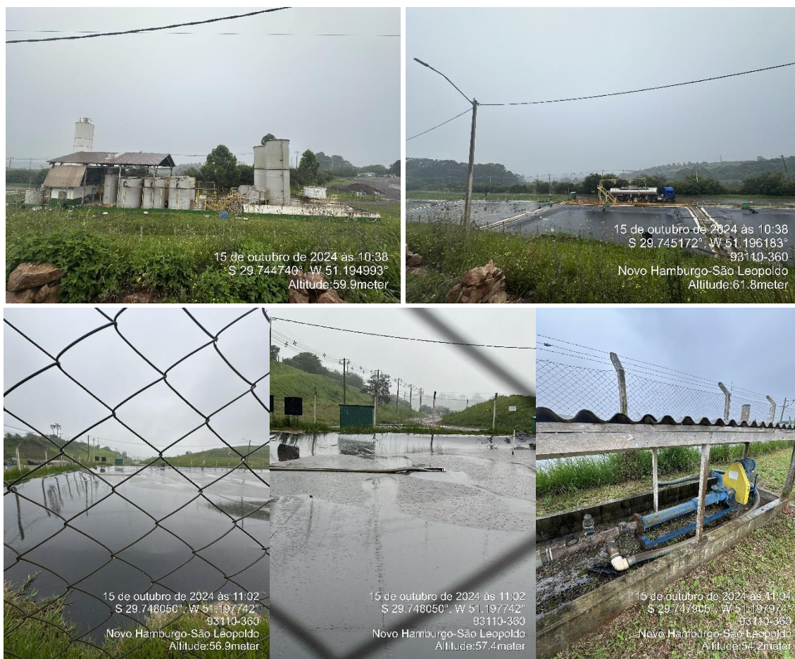
Figura 5: ETE desativada e lagoas de acúmulo de chorume
