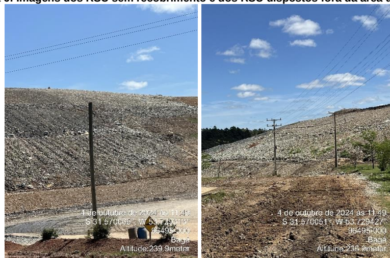
Figura 6: Imagens dos RSU sem recobrimento e dos RSU dispostos fora da área da célula
