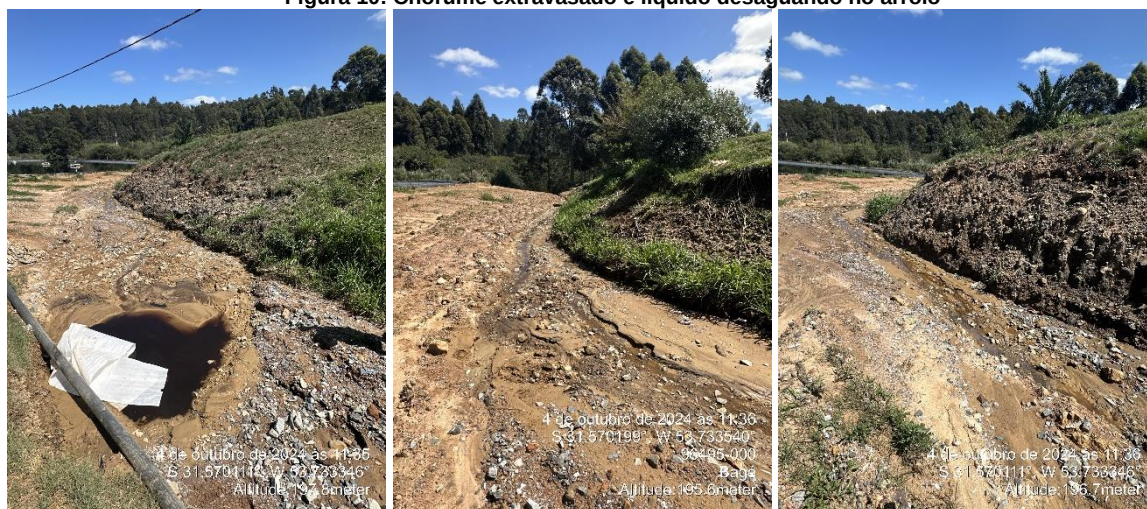
Figura 10: Chorume extravasado e líquido desaguando no arroio
