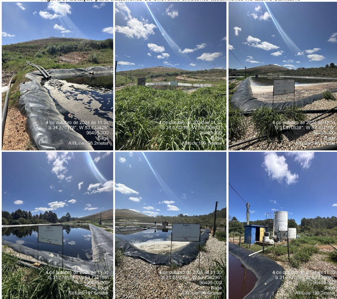
Figura 9: Estação para tratamento de chorume existente atualmente no aterro sanitário
