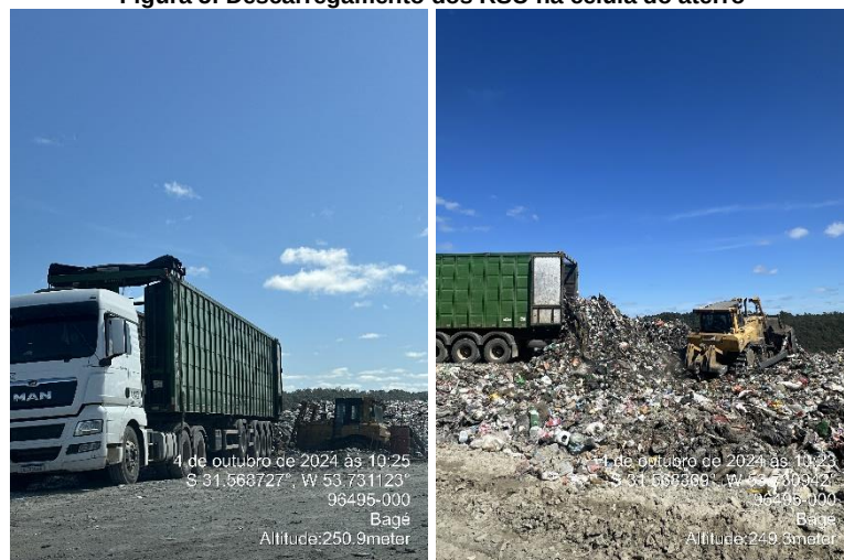
Figura 5: Descarregamento dos RSU na célula do aterro
