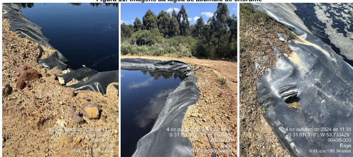
Figura 11: Imagens da lagoa de acúmulo de chorume
