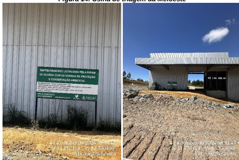
Figura 14: Usina de triagem da Meioeste
