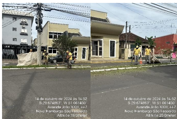
Figura 14: Limpeza urbana sendo executada
