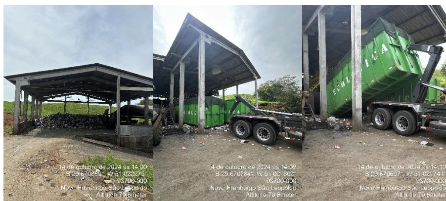
Figura 6: Estrutura utilizada para a transbordo dos RSU
